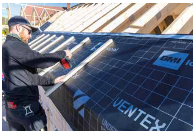
Ventex Undertak Premium - diffusjonsåpent undertak.
